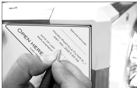
8. Wypełnij etykietę datą następnej wymiany filtrów i przyklej ją po zewnętrznej stronie drzwiczek. Wymiana taka powinna odbywać się 1 x 3 lata.
