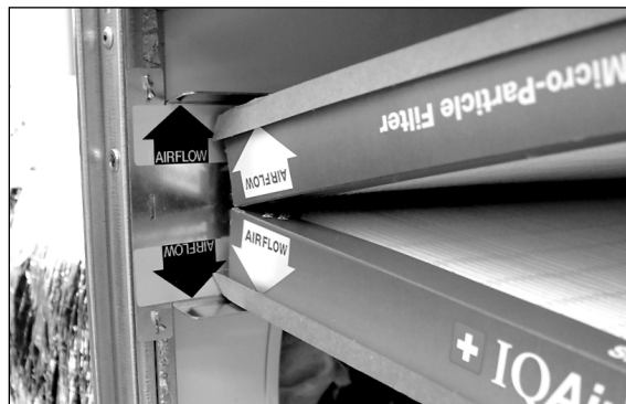
6. Upewnij się, że filtry są prawidłowo włożone wg strzałek na filtrach i na obudowie Perfect 16
