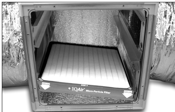
5. Następnie wkładaj nowe filtry zaczynając od dolnego.
