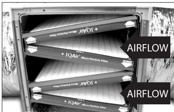
7. Sprawdź dokładnie czy filtry są umieszczone prawidłowo.
