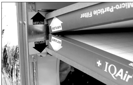
7. Jeszcze raz upewnij się, że prawidłowo zostały dopasowane filtry zgodnie z oznaczeniami na nich i w komorze Perfect 16.
